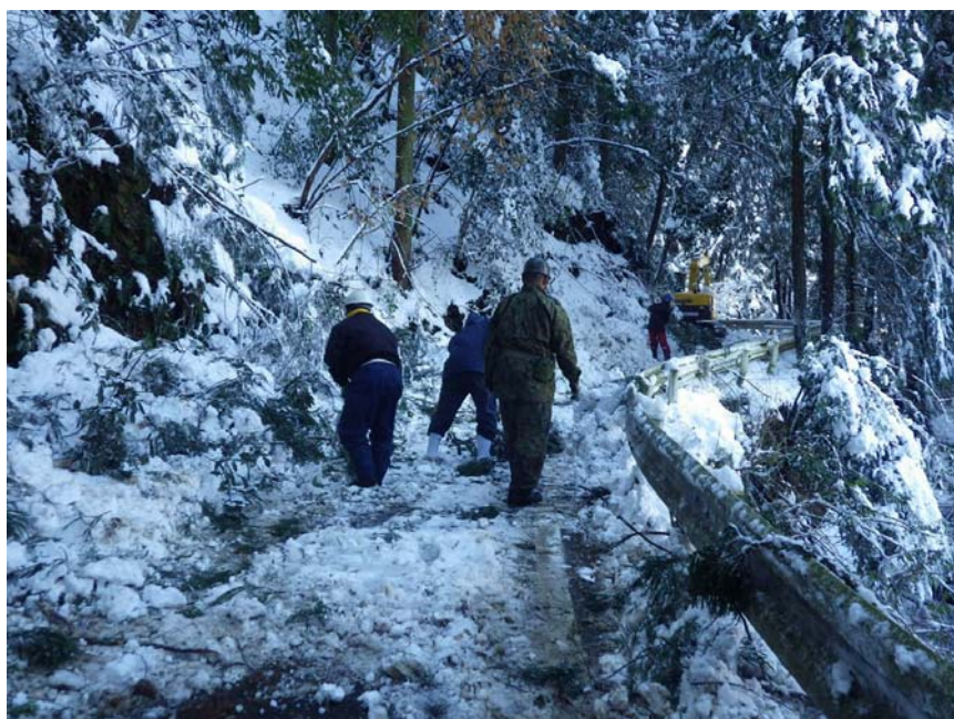
写真1 自衛隊と連携した道路啓開
