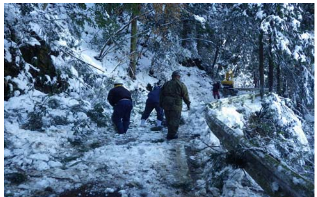
写真-1 雪害時の自衛隊と連携した道路啓開
